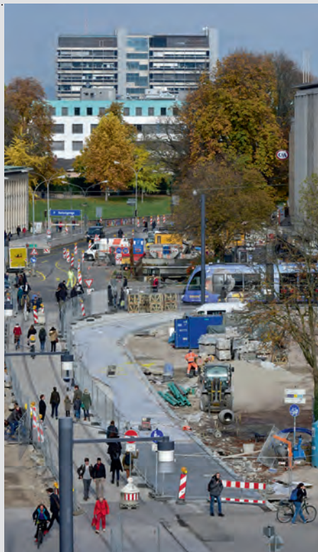
Eine große Baustelle ist noch, was einmal ein neues Herzstück für Freiburg sein soll. Foto: Thomas Kunz
