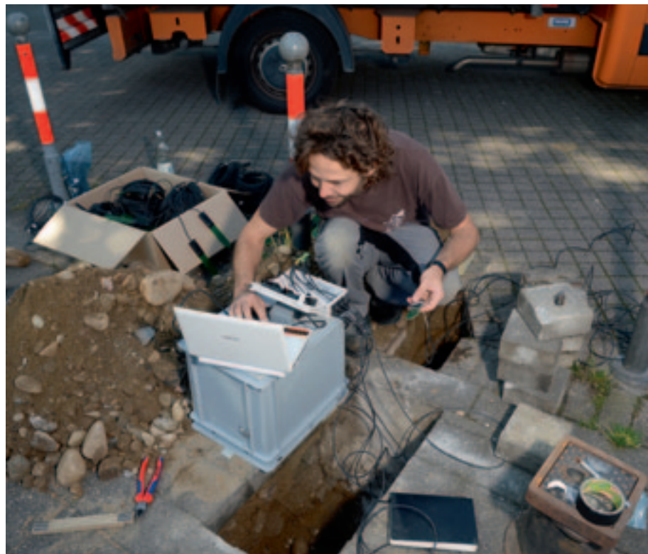
Installation von Sonden unter einer gepflasterten Fläche: Mit den Messinstrumenten stellen Hydrologen fest, wie viel Niederschlag fällt und wie viel Wasser versickert oder abfließt.
